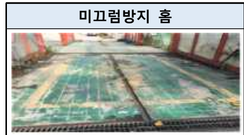
[ 미끄럼방지 흙 설치 사례 ]
